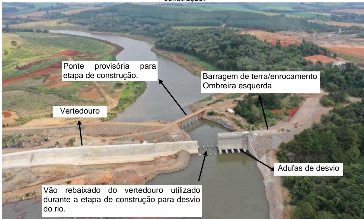
Figura 4 – Fotografia da margem esquerda e parte do vertedouro da barragem da PCH São Luis em construção.
