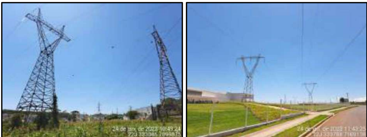
Figura 5 – Linhas de transmissão de alta tensão (230 kV) existentes no trecho urbano (Pato Branco).
