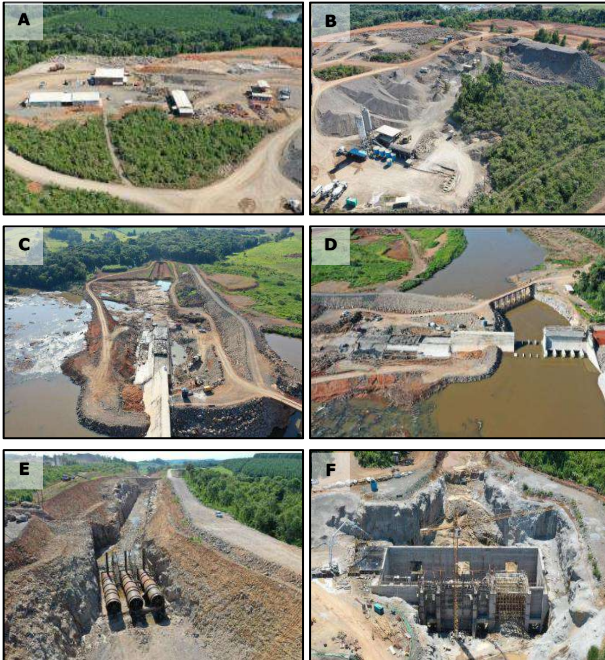
Figura 2 – Registros fotográficos do canteiro de obras e estruturas da PCH São Luís.
