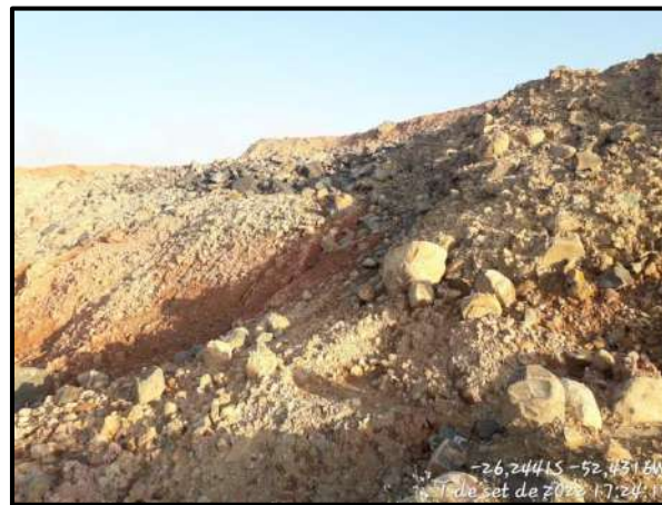
Figura 55 – Sulcos erosivos em talude do bota-fora principal.
