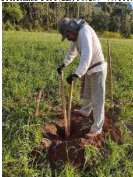
Figura 89: Procedimento de escavação da sondagem 20. Coordenada UTM (22J) 360264 - 7093009.
