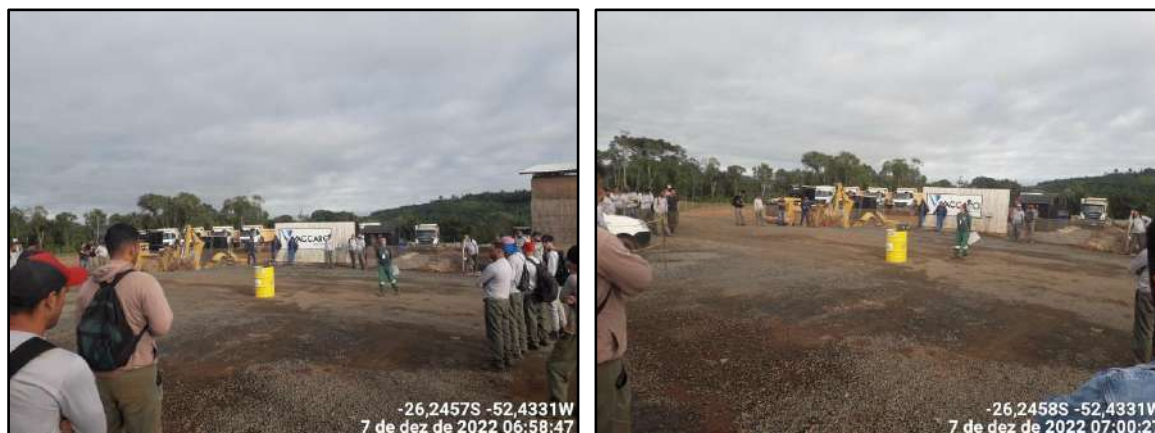
Figura 64 - Realização de DDS no segundo semestre de obras.
