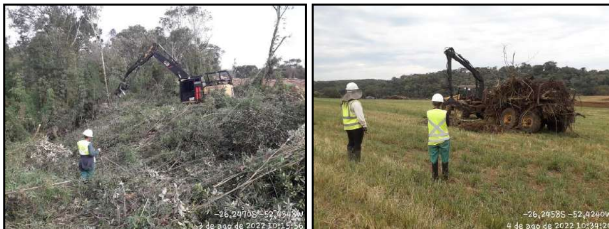
Figura 90 - Acompanhamento da supressão de vegetação do acesso (esquerda) e limpeza do reservatório (direita).
