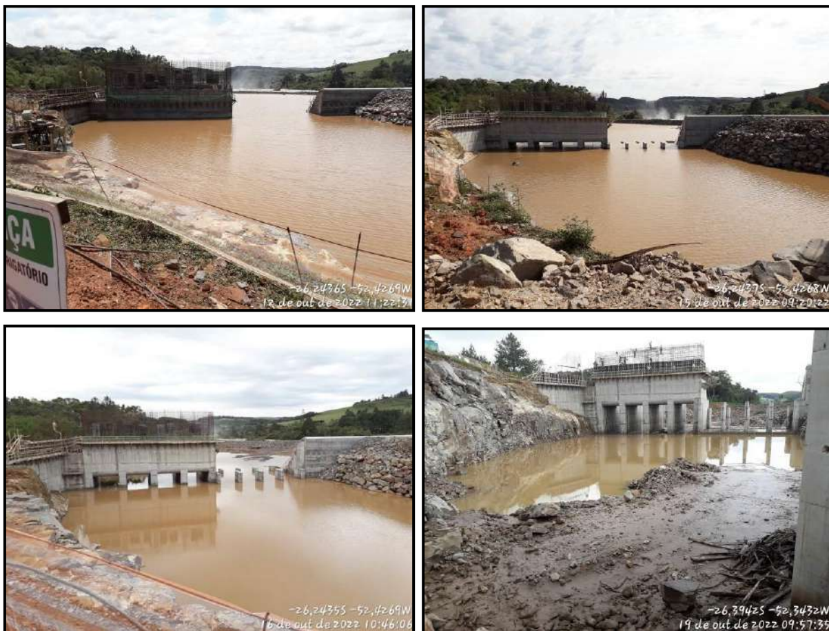
Figura 14 - Acompanhamento da evolução do processo de retirada de água e limpeza no barramento.
