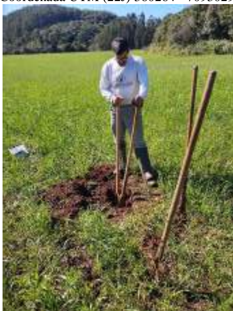
Figura 69: Procedimento de escavação da sondagem 10. Coordenada UTM (22J) 360264 - 7093029.
