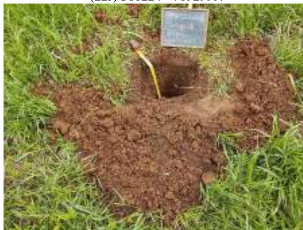
Figura 92: Sondagem 21 finalizada. Coordenada UTM (22J) 360224 - 7092999.
