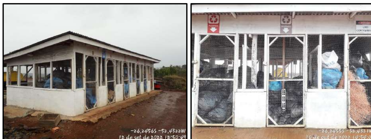
Figura 29 - Registros fotográficos das baias de resíduos sólidos da PCH São Luís.
