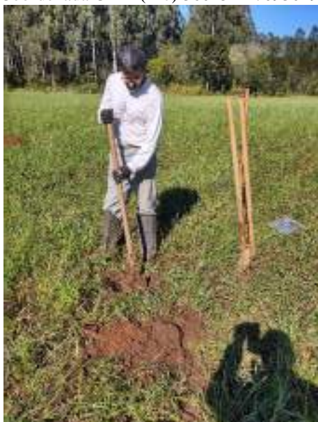
Figura 67: Procedimento de escavação da sondagem 09. Coordenada UTM (22J) 360254 - 7093029.
