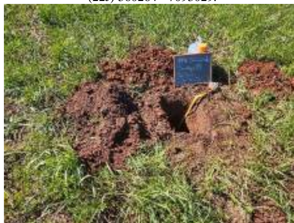
Figura 70: Sondagem 10 finalizada. Coordenada UTM (22J) 360264 - 7093029.
