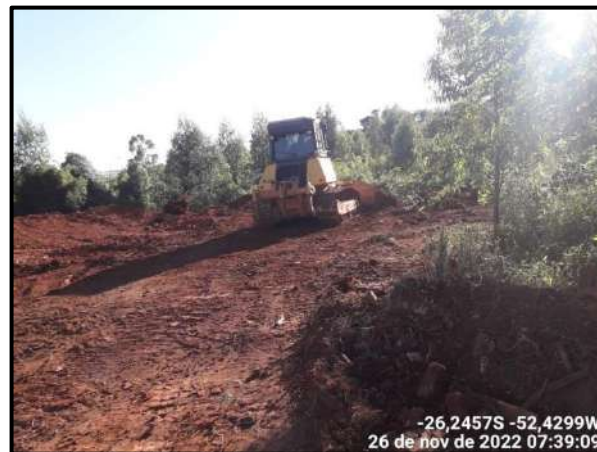
Figura 107 – Início do monitoramento de nova área de bota-fora.
