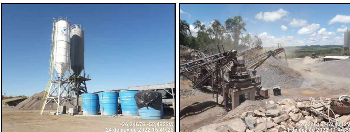
Figura 11 - Acompanhamento das atividades na central de concreto (esquerda) e britador (direita).
