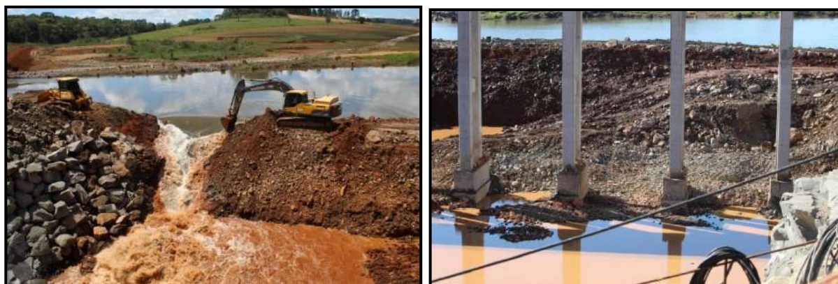
Figura 16 - Acompanhamento do desvio do rio 2ª fase.
