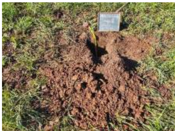
Figura 73: Sondagem 12 finalizada. Coordenada UTM (22J) 360234 - 7093019.
