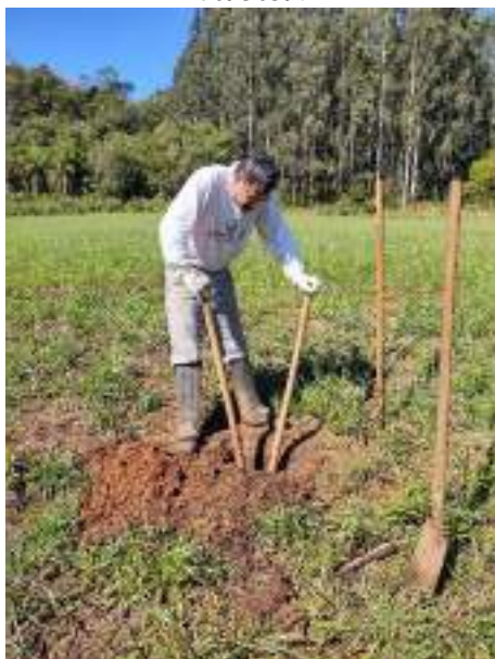
Figura 55: Procedimento de escavação da sondagem 03. Coordenada UTM (22J) 360244 - 7093039.
