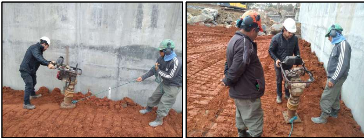
Figura 149 - Treinamento para utilização correta de compactador manual.
