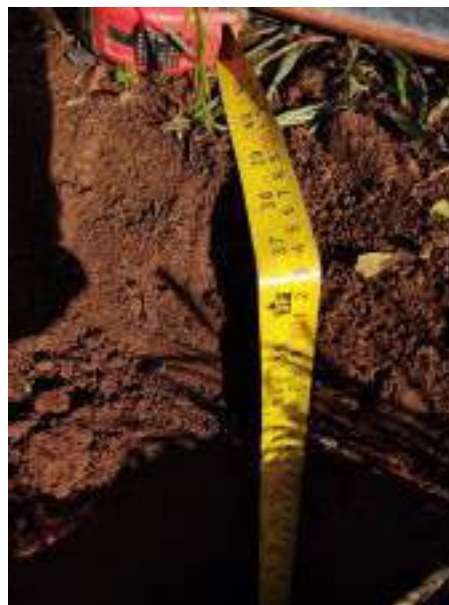
Figura 96: Sondagem 23 finalizada. Coordenada UTM (22J) 360244 - 7092999.
