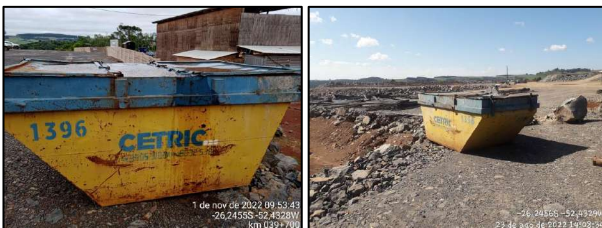
Figura 33 - Caçamba utilizada para o acondicionamento de resíduos perigosos ou contaminados.
