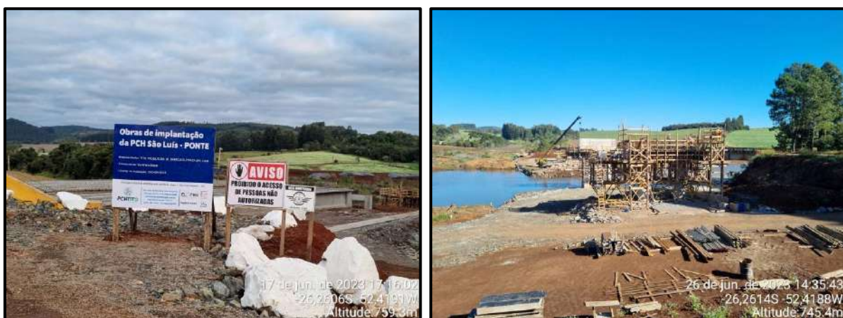
Figura 14 - Placa de identificação da obra (esquerda) e acompanhamento da obra (direita).
