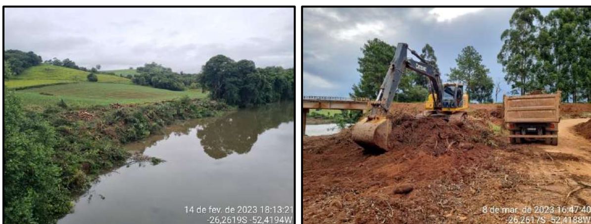
Figura 13 - Acompanhamento da supressão de vegetação (direita) e limpeza (esquerda) na área da ponte.
