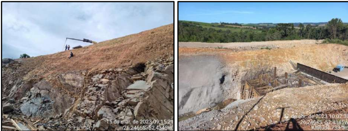
Figura 56 – Aplicação de concreto projetado na área do conduto forçado.
