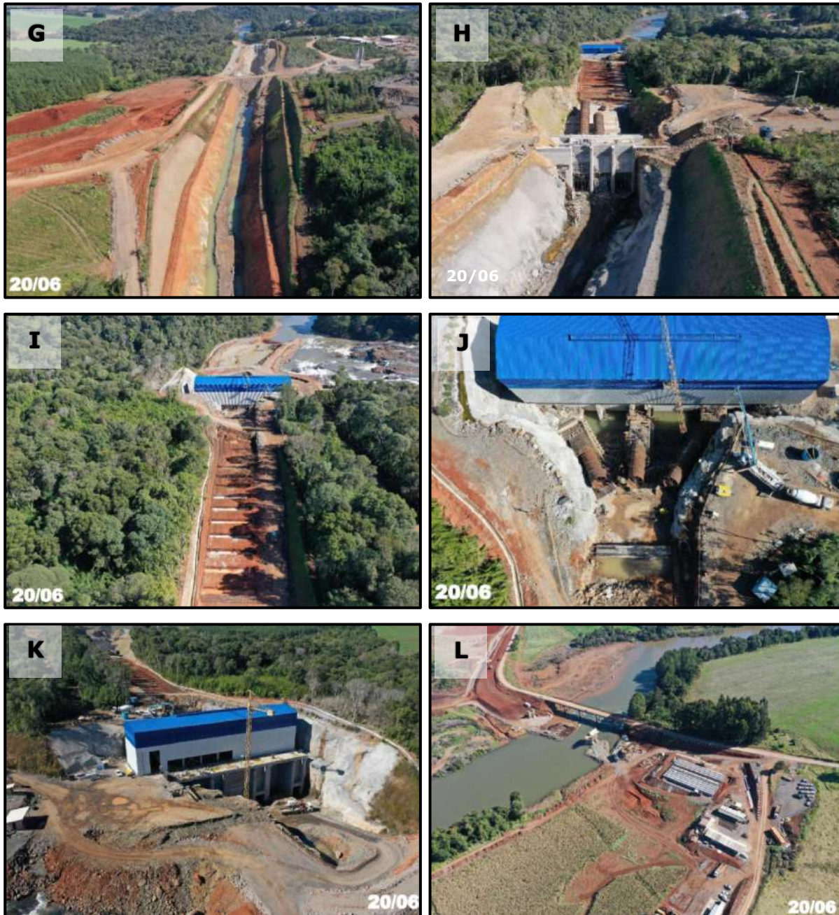
Figura 3 – Registros fotográficos do canteiro de obras e estruturas da PCH São Luís.
