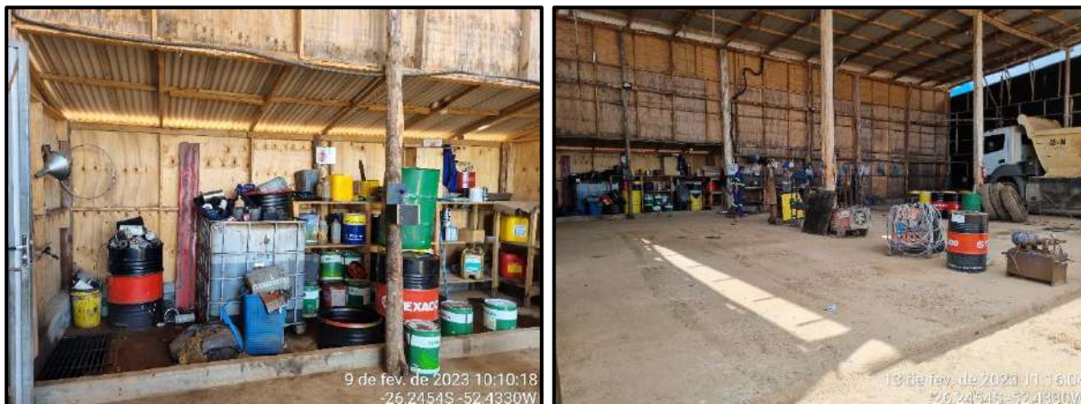
Figura 33 - Central de armazenamento de produtos perigosos.
