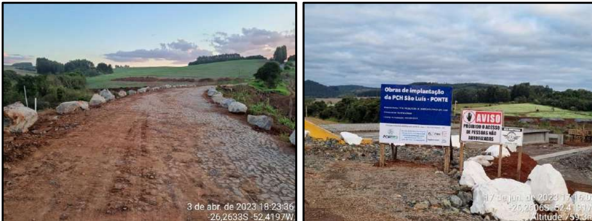
Figura 171 - Sinalização e medidas de segurança pra as atividades de construção da ponte.
