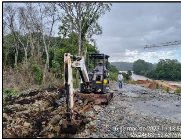
Figura 126 - Construção de canaleta para direcionar o fluxo d'água.
