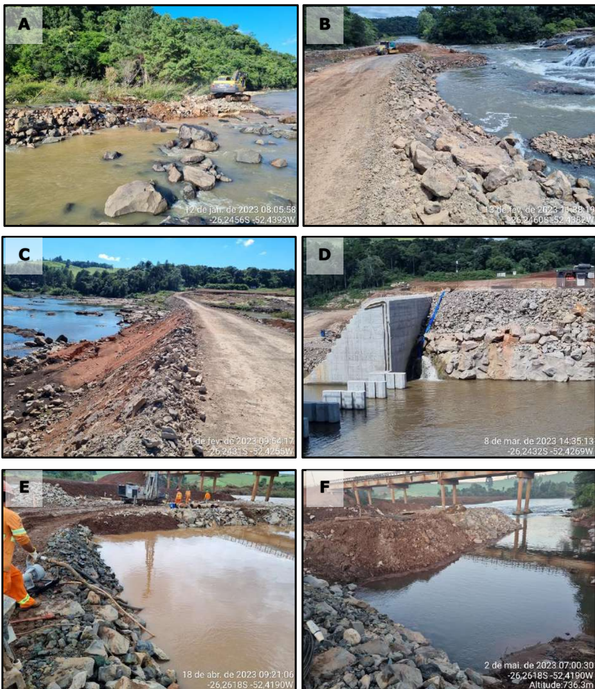
Figura 93 – Locais vistoriados que estão em conformidade.
