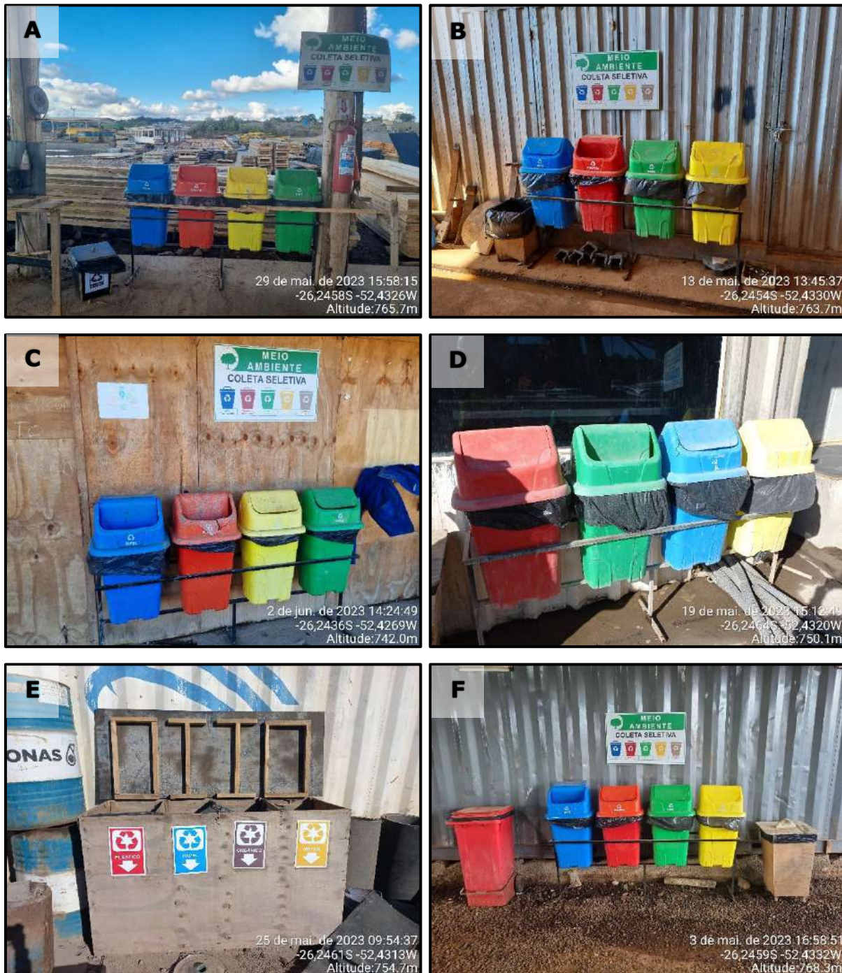
Figura 29 - Registros fotográficos dos coletores instalados na PCH São Luís.
