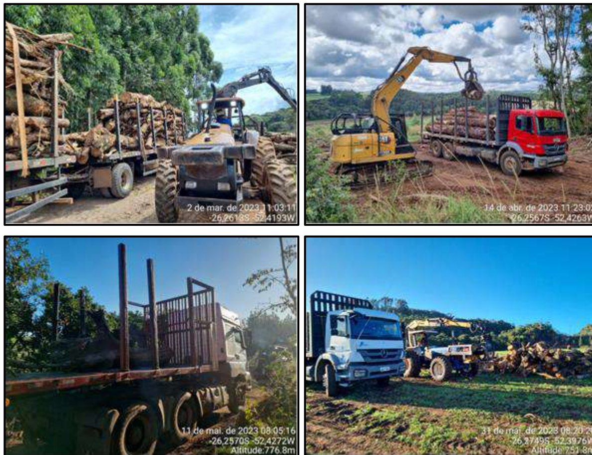
Figura 103 – Remoção do material lenhoso.
