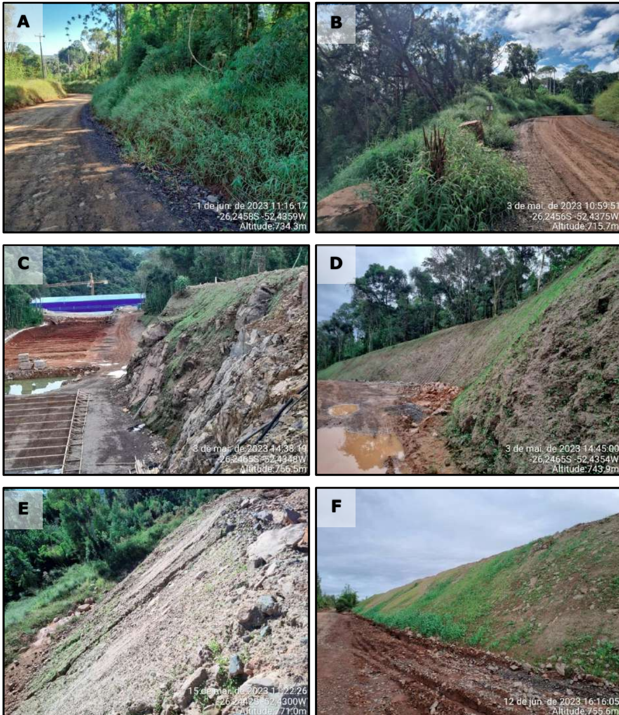
Figura 55 - Implantação de hidrossemeadura preventiva em taludes.
