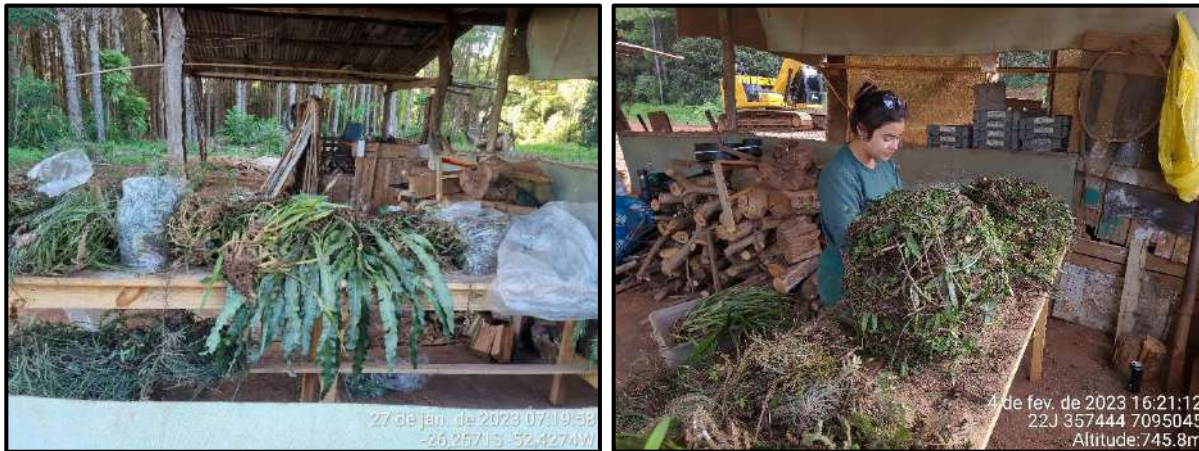
Figura 108 - Centro de apoio dentro do canteiro de obras para triagem de epífitas.
