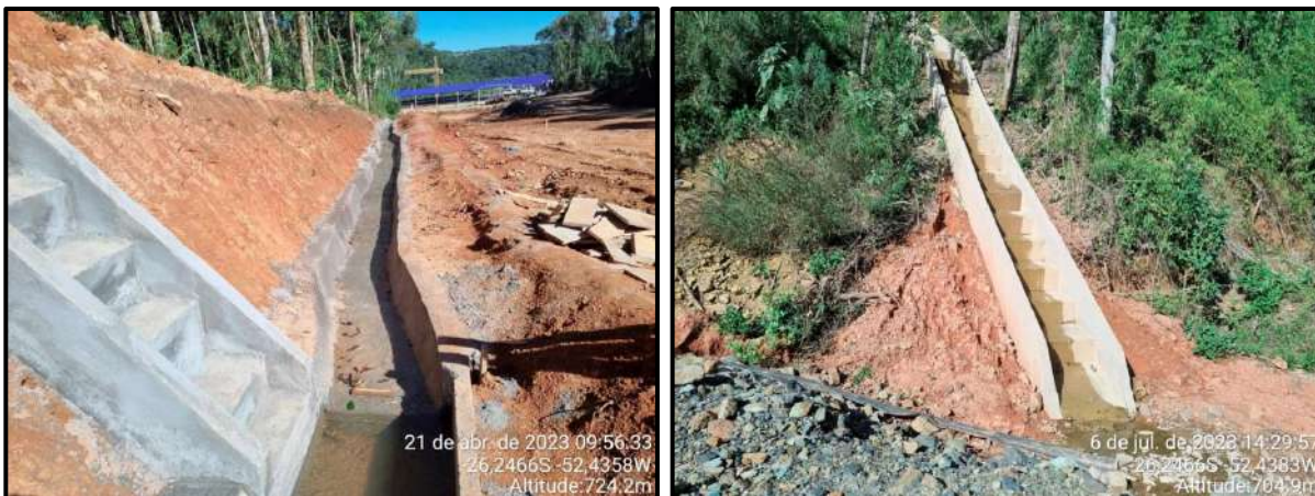
Figura 57 – Construção de sistemas de drenagem.
