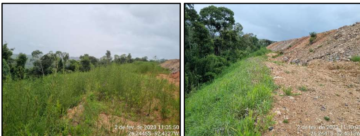
Figura 125 - Monitoramento de área de bota fora.
