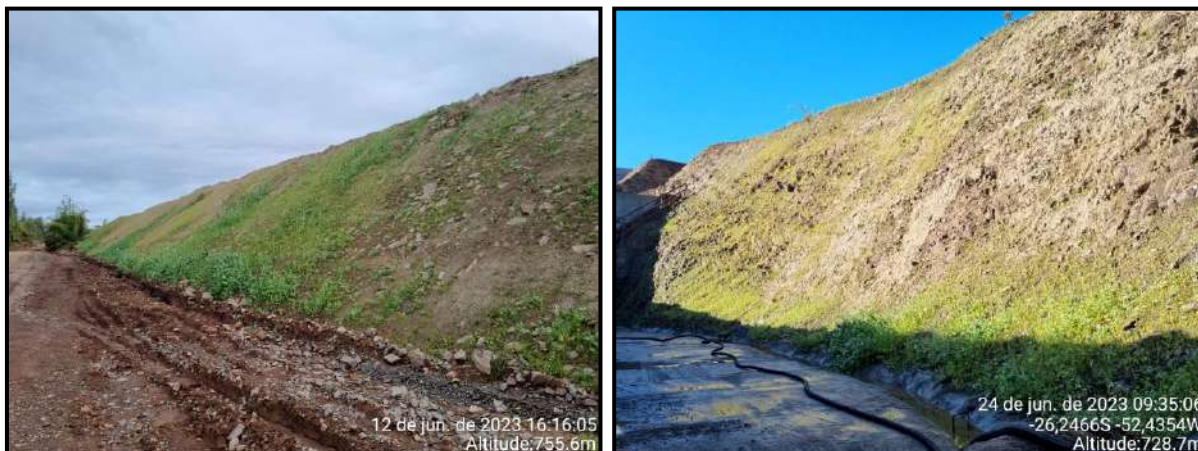
Figura 124 – Inspeção de recuperação de taludes.
