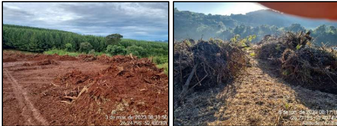
Figura 129 - Incorporação de galharia na futura APP do reservatório e bota-fora.
