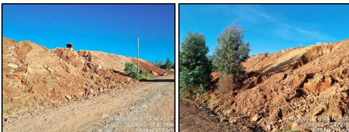
Figura 59 – Incisão de ravinas em associação com deslizamentos rotacionais em talude de bota-fora.
