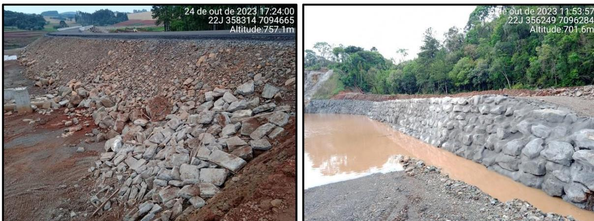
**Figura 60 – Proteção de taludes com enrocamento.**
