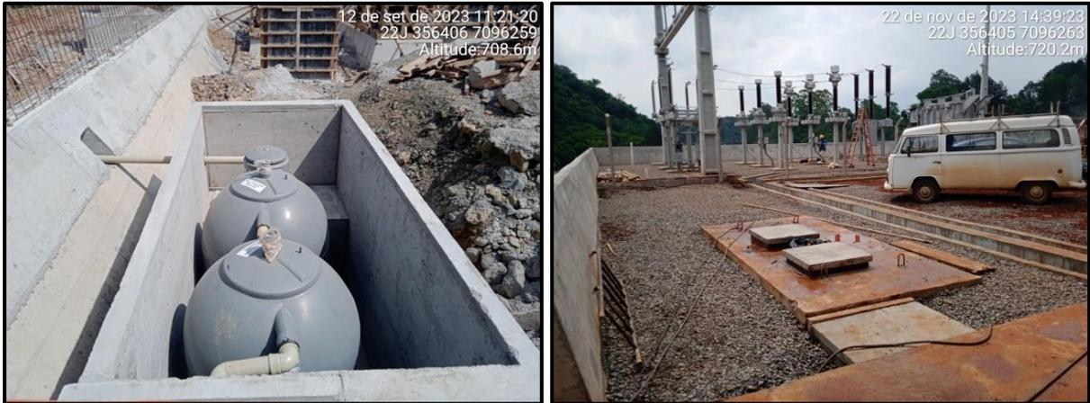
**Figura 52 – Sistema de tratamento de efluente sanitário instalado.**
