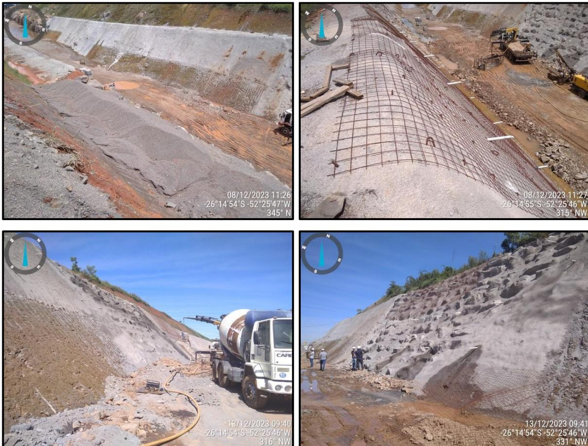
**Figura 59 – Proteção de taludes com concreto projetado.**
