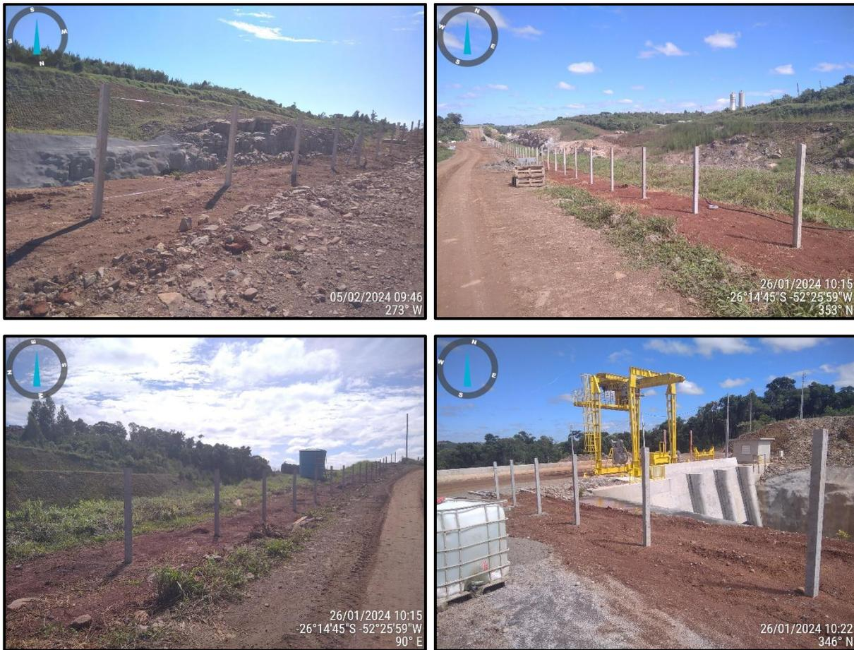
**Figura 17 – Registro fotográfico da execução de isolamento do entorno do canal de adução.**
