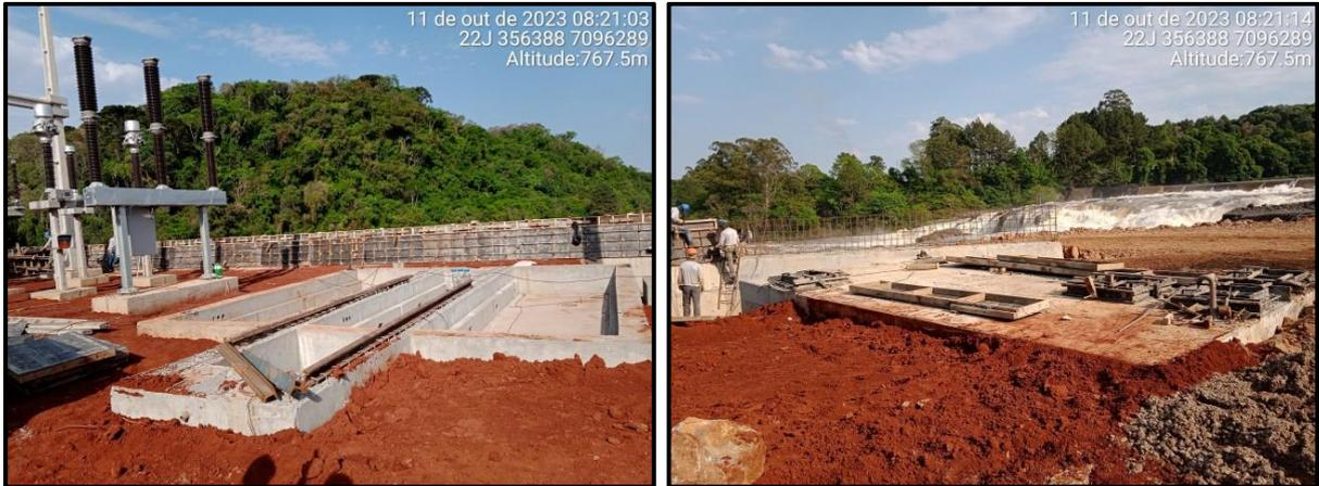
**Figura 49 – Bacia coletora e caixa SAO do Trafo.**
