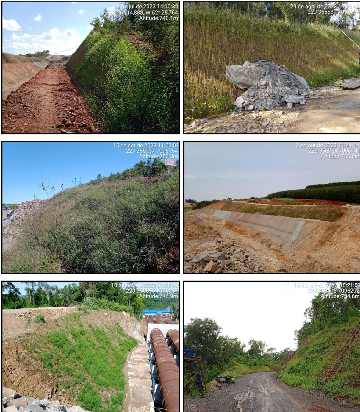
**Figura 56 – Implantação e monitoramento de coberturas vegetais aplicadas em taludes expostos.**
