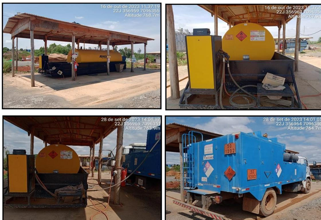
**Figura 191 - Tanque de armazenamento de combustíveis e dispositivos de controle e contenção de vazamentos.**
