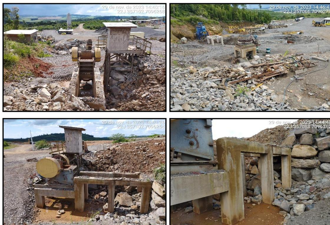
**Figura 192 - Desmobilização do britador localizado no canteiro de obras.**
