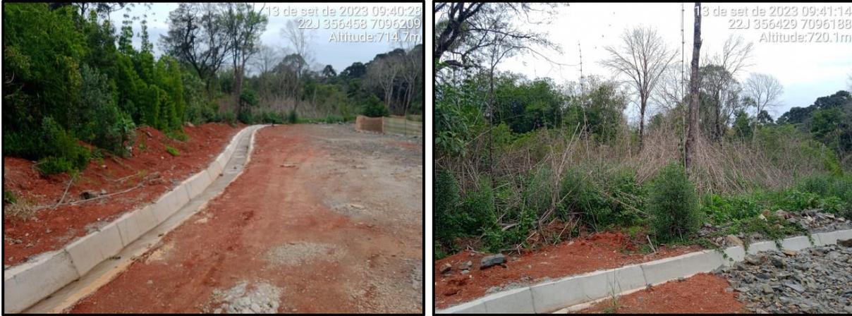
**Figura 109 - Construção de canaleta para direcionar o fluxo d'água.**
