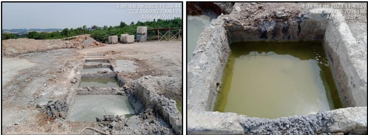
**Figura 47 - Estrutura de bate-lastro para limpeza de caminhões-betoneira.**
