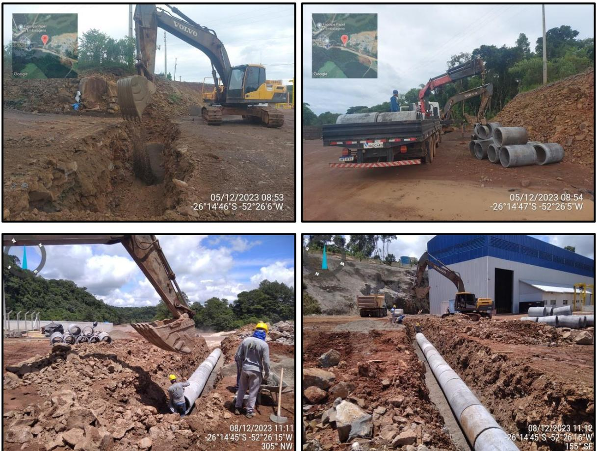
Figura 58 – Construção de sistemas de drenagem.
