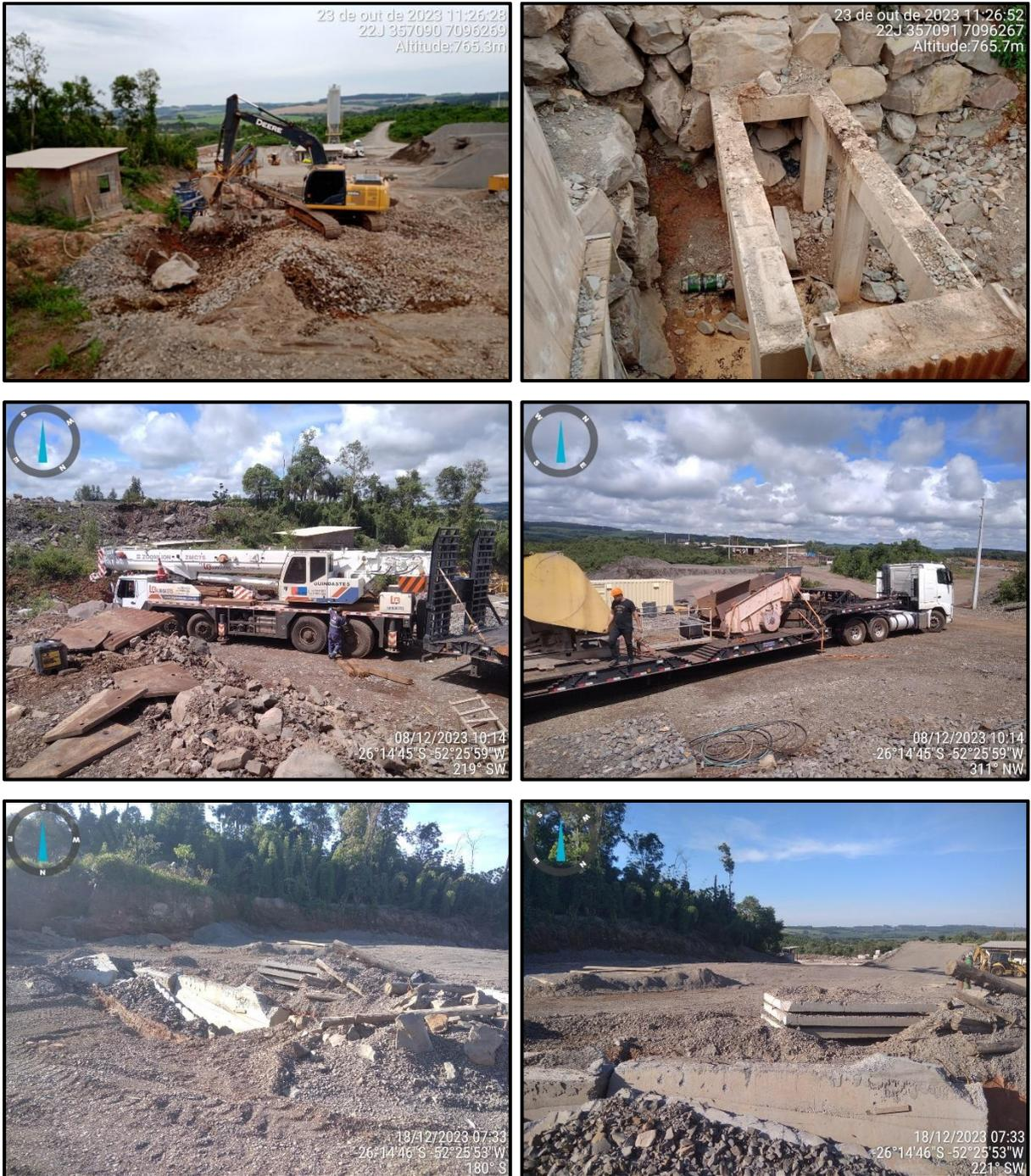
**Figura 74 – Registro da desmontagem e desmobilização de estruturas da central de britagem.**
