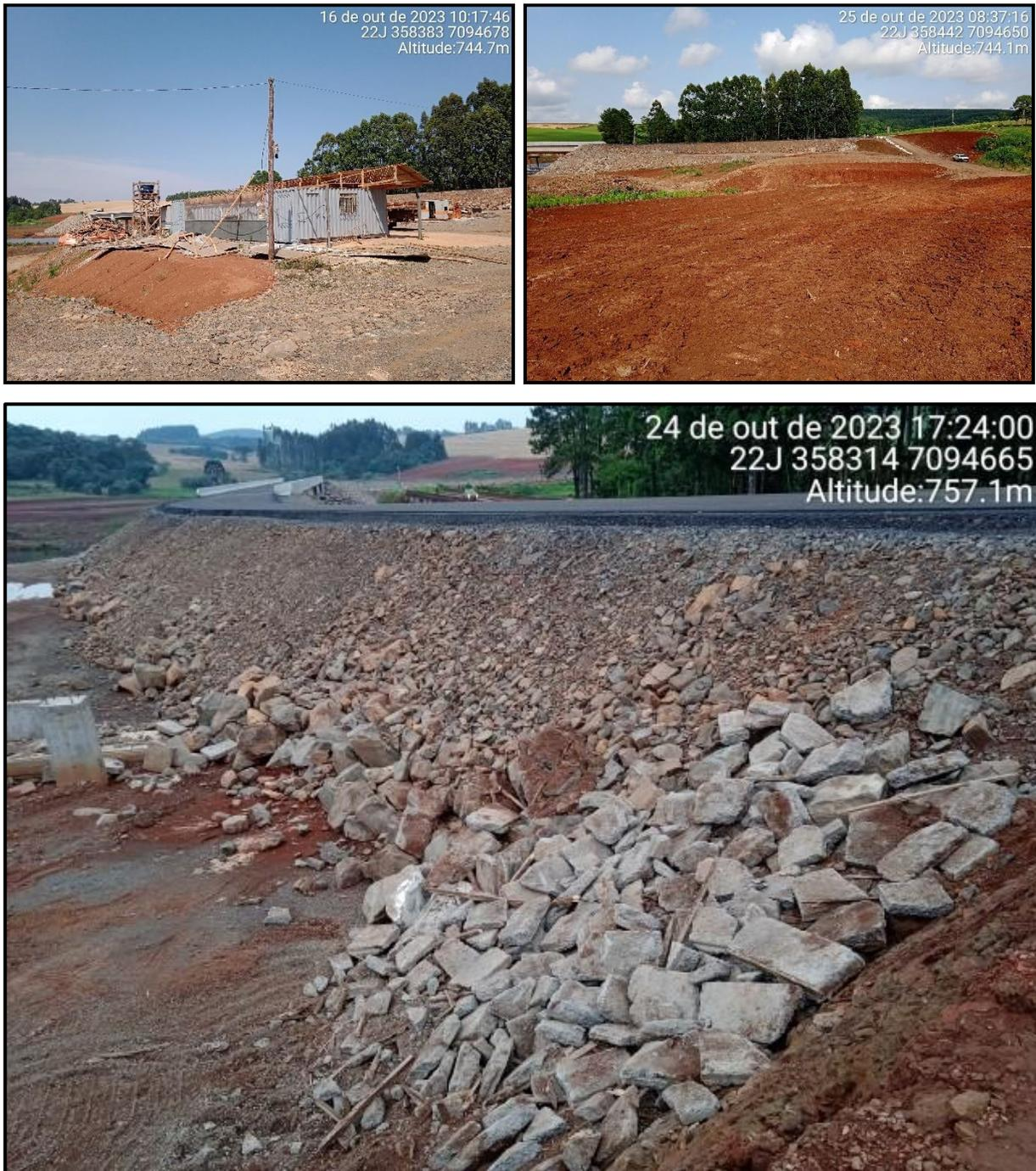
**Figura 75 - Desmobilização do canteiro de obras da ponte intermunicipal e reaproveitamento de pisos para proteção de taludes.**
