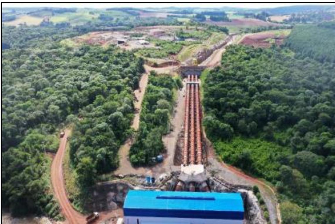
**Figura 6 – Conduitos forçados.**
