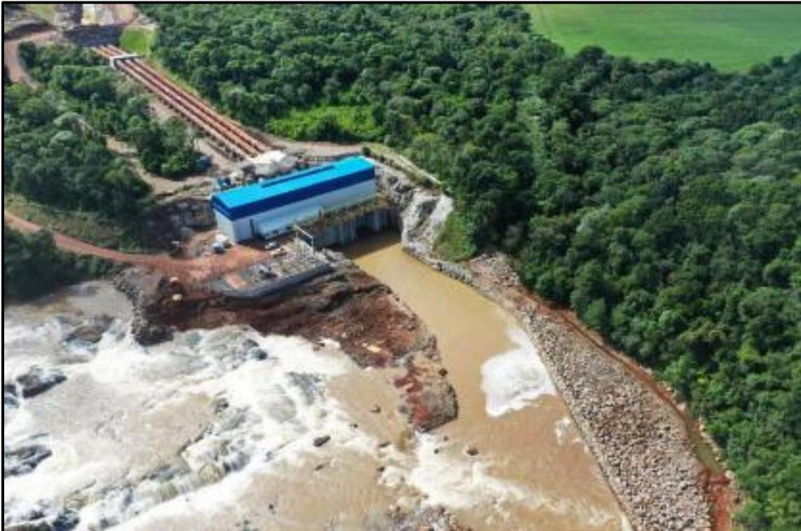
**Figura 7 – Casa de força, subestação e canal de fuga.**
