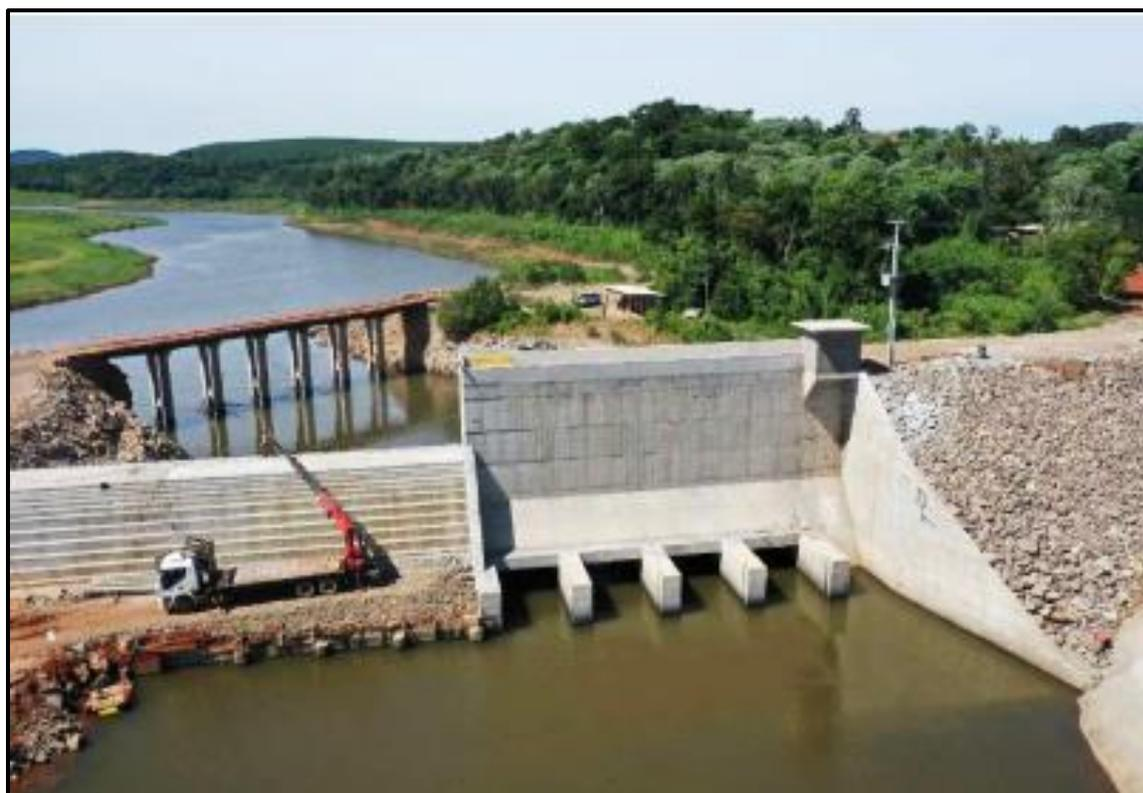
**Figura 3 – Vertedouro, estruturas de desvio e ombreiras da barragem.**
